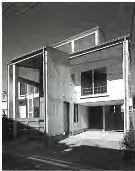
▲写真4/南東側外観。軒下には日除けルーバー
