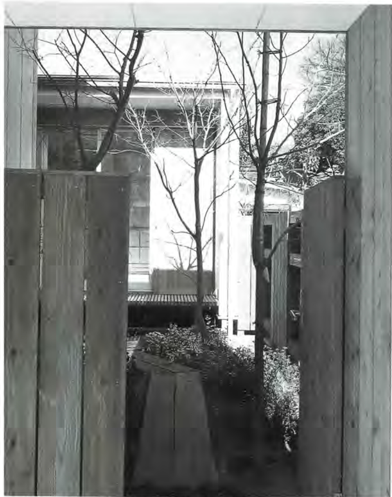
▲写真1 /カーポートから光の庭を見る。板雨戸は開きやすい下レールはなく、ハンガーレールで吊る。開放している時はこうして戸袋のように見える
