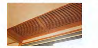
2階にある小屋裏換気口の閉閉レバ。10か所のうち、2つが室内の換気用、8つが内壁空洞専用
