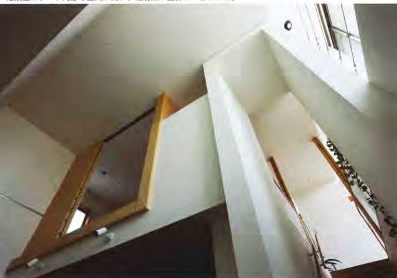
階段室のゲート内部も空気が流れ、輻射熱が全体にいきわたる。
