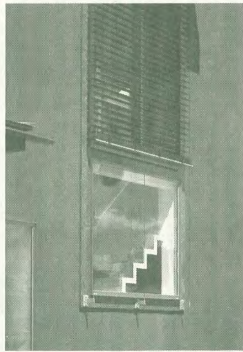
写真3 夏場の東面を外付けルーバーで覆うと効果的（撮影：黒住 直臣）
